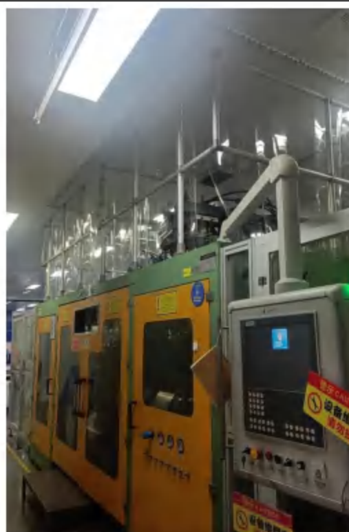
吹瓶车间密闭+设备垂帘
